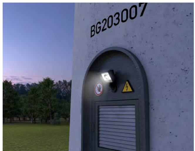
Abb. B4-1 Zugang mit ausreichender Außenbeleuchtung
