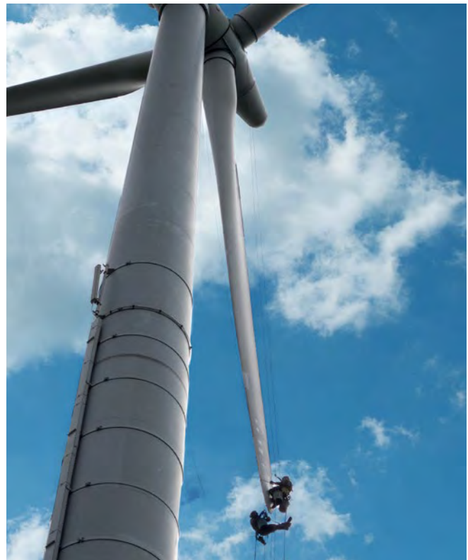
Abb. A13-3 Arbeiten am Rotorblatt
