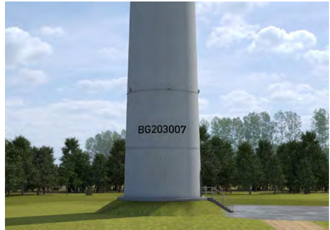
Abb. A13-6 Kennzeichnung WEA (Anlagennummer) wegseitig
