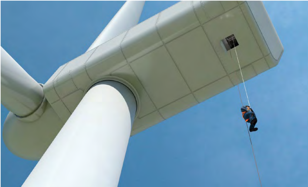
Abb. A13-5 Abseilen aus dem Maschinenhaus (Übung)
